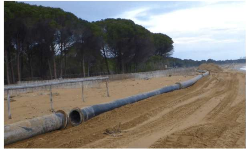
Allestimento cantiere Sabbiodotto
